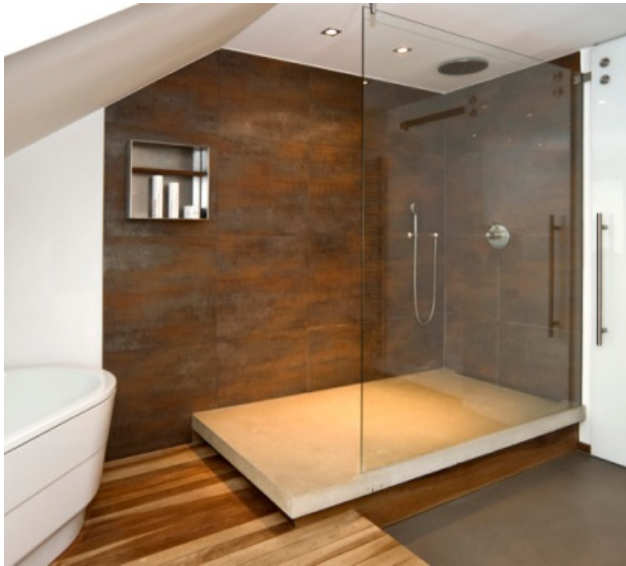
Bild 1: Duschtasse aus Sichtbeton
