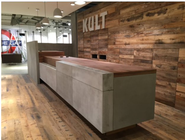
Bild 2: Verkaufstresen aus Sichtbeton
